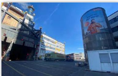
Mit einem Durchsatz von 1 Mio. Tonnen Müll pro Jahr und einer Leistung von 400 MW liefert die von der Wien Energie betriebene Müllverbrennungsanlage (MVA) neben elektrischer Energie auch Fernwärme und -kälte seit den 60er Jahren. Die Anlage, wie wir sie heute kennen, wurde 1992 eröffnet.
