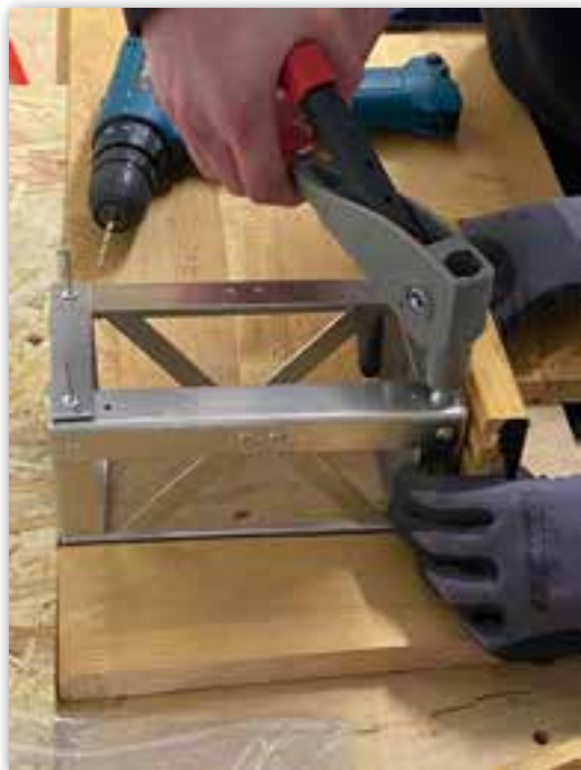
Zusammenbau des Turmdrehkrans.
